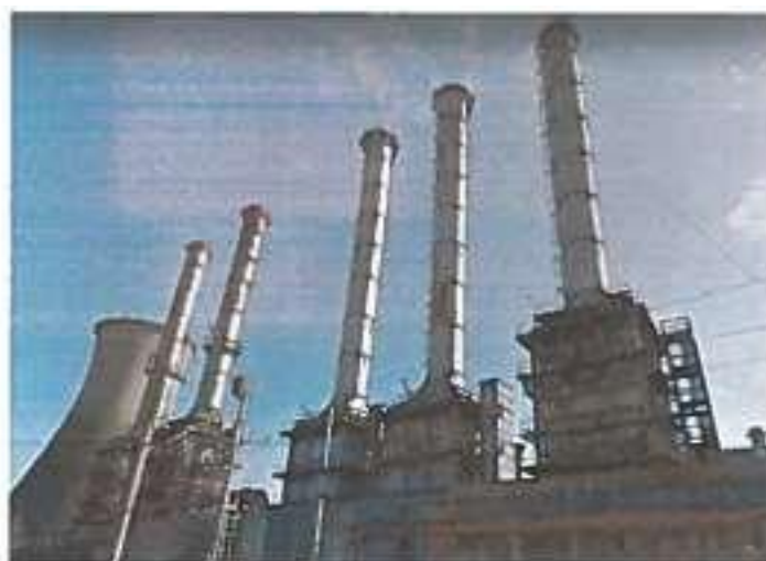
Figura nr. 13 Fotografie cazane existente
